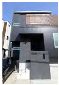
周囲と一線を画す黒い壁面の外観がシック。テラスに付けた木目調の柵がアクセントに
