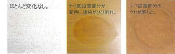
ほとんど変化なし。 ナベ底設置部分が変色し塗装がひび割れ。 ナベ設置部分のツヤが落ちた。 メラミン系カウンター 集成カウンター オレフィンカウンター
